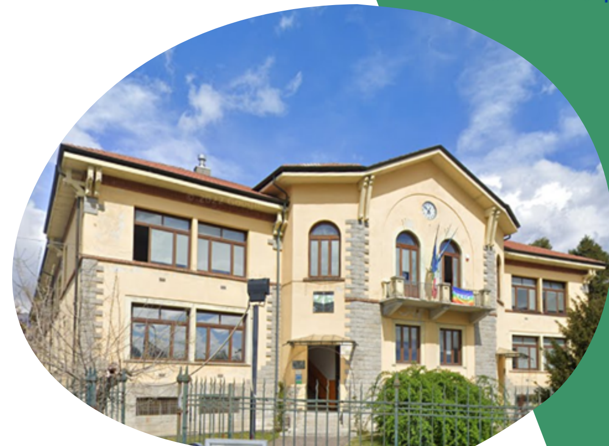
Edificio di Lanzo
